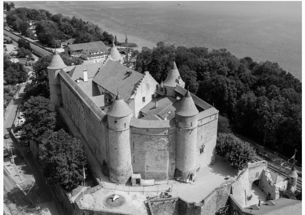
Schloss Grandson am Neuenburgersee, das bis 2026 umfassend saniert wird.
